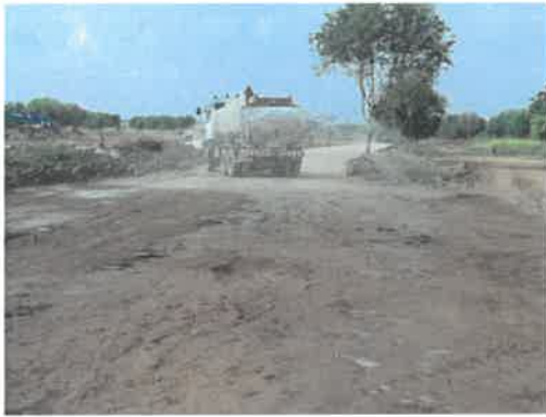
ภาพที่ 2.2-3 ฉีดพรมพื้นที่ก่อสร้าง
